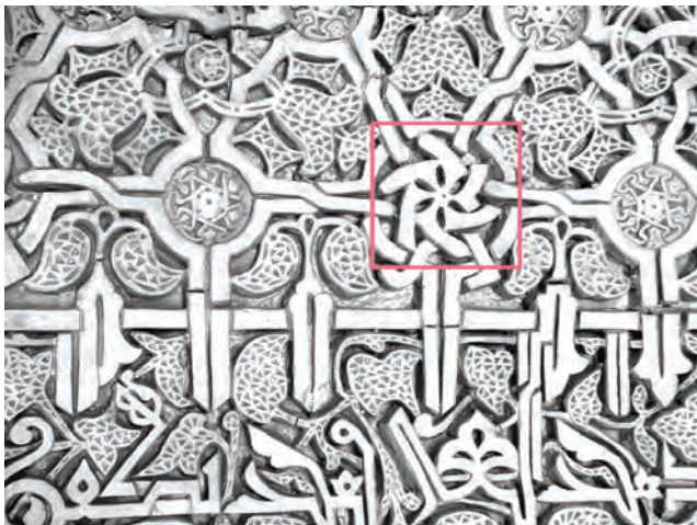
شکل ۳۳-۶. بخشی از گجبری مسجدی در ارومیه
